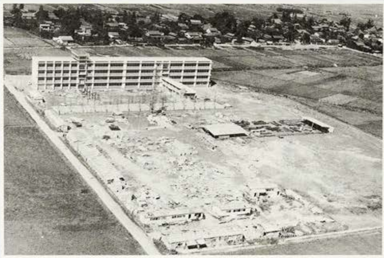
開校当時の全景。グラウンドの4分の3はまだ工事で使用できなかった(昭和38年9月)
