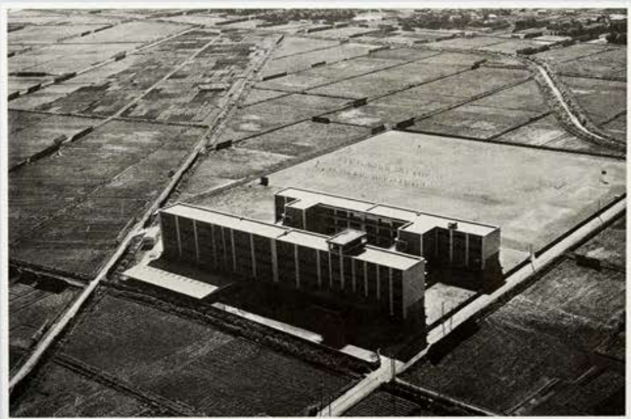
第2期工事竣工。南館・校門も完成した(昭和39年4月)
